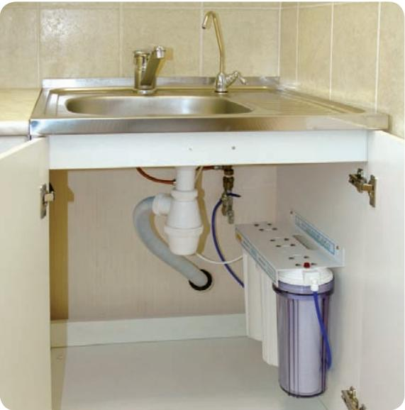
Рис. 4.22. Пример размещения фильтра «Водолей-БКП» под мойкой.
