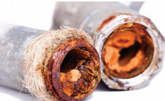
Рис. 2.1. Техническое состояние трубопроводов распределительных сетей.
